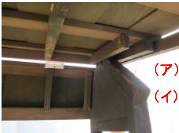
⑤屋根部のクボミ(ア)に横枠天上部(イ)への字に入れ組み立てます。
