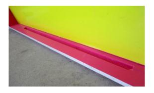
④左右の板を固定ネジで止めます。
